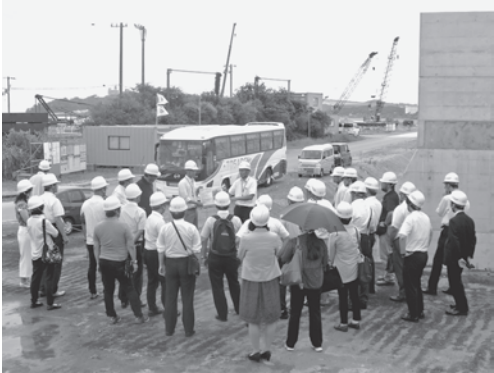
浦戸湾工事現場見学
