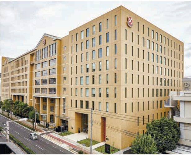
聖テモテ館全景(手前の9階建ビル型校舎)あべのBDLは4階から9階に設置
