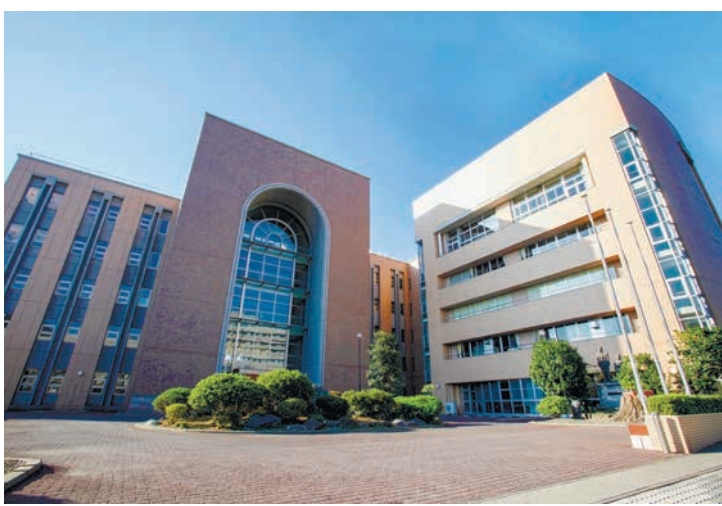
外観(群馬県前橋市昭和町3-7-27)
