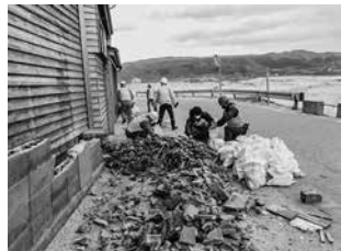
瓦礫撤去ボランティア
